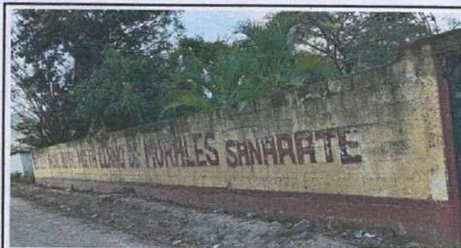
Foto 3: Aplicación de pintura en muro exterior
