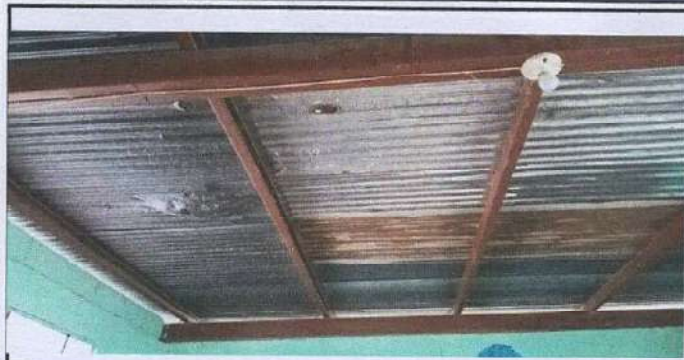
Foto1: Mantenimiento de estructura metálica, lijado, pintura y sustitución de lámina por lámina troquelada
