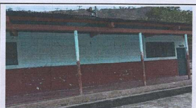
Foto 4: Pintura de muro perimetral interior y exterior
