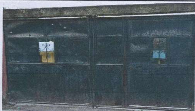
Foto 7: Reparación de puertas de metal
