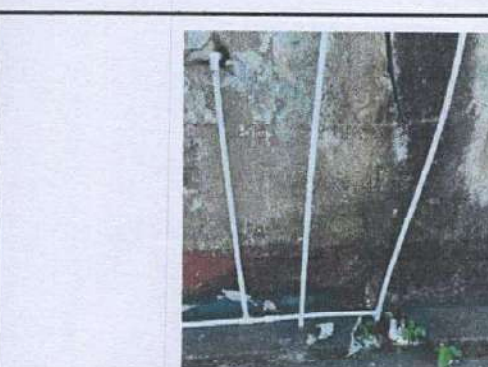
Foto 6: Sustitución de red de agua
