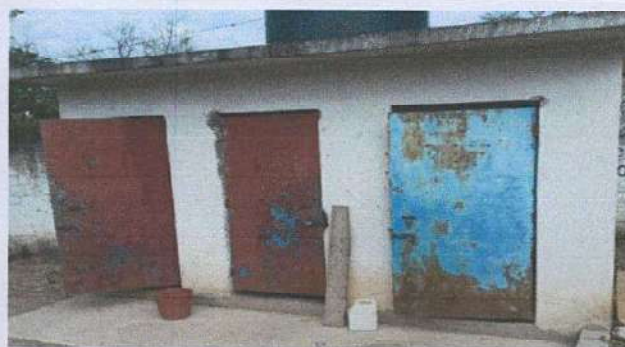
Foto 8: Reparación de puertas de metal de servicios sanitarios
